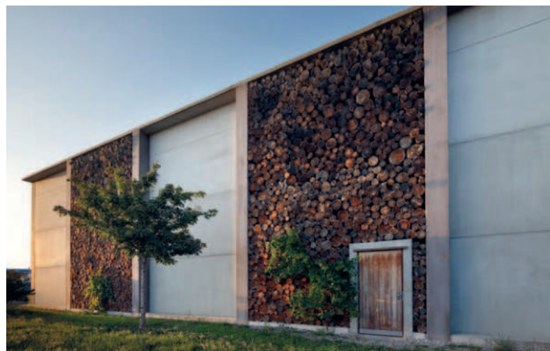
Ökologische Nischen durch Integration von Holzrundlingen in der Fassade
