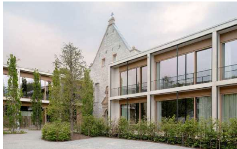
Serienfaktor: Nachhaltige und wirtschaftliche Nutzung der Schalung (hier nur 6 Schalungen für 264 Fertigteile)
