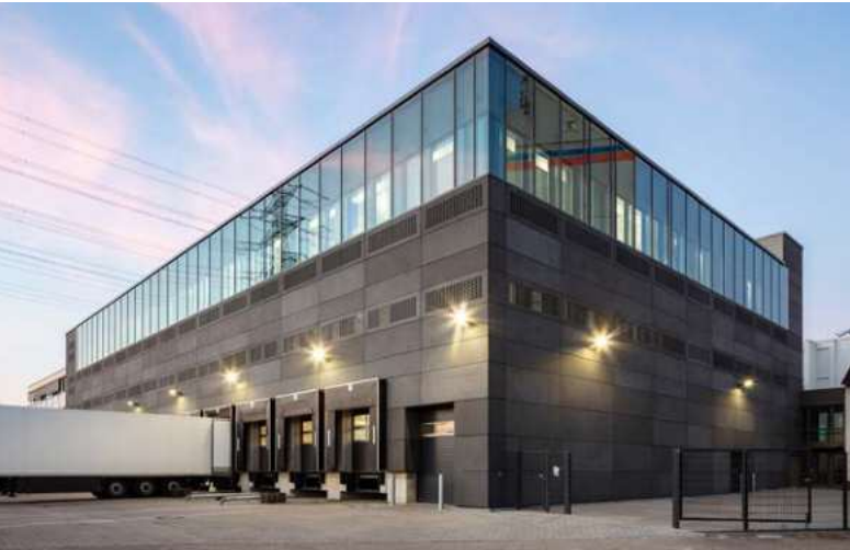
Gelochte dünne Fassadenelemente mit Carbonbewehrung und einer gesäuerten Oberfläche
