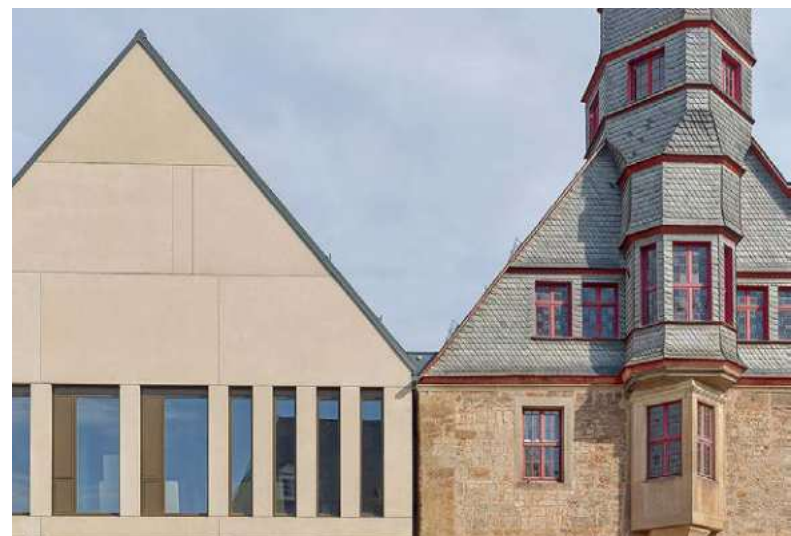
Fassadenelemente aus Recyclingbeton unter Verwendung des vor Ort rückgebauten Gebäudes als Beton- und Ziegelrezyklat
