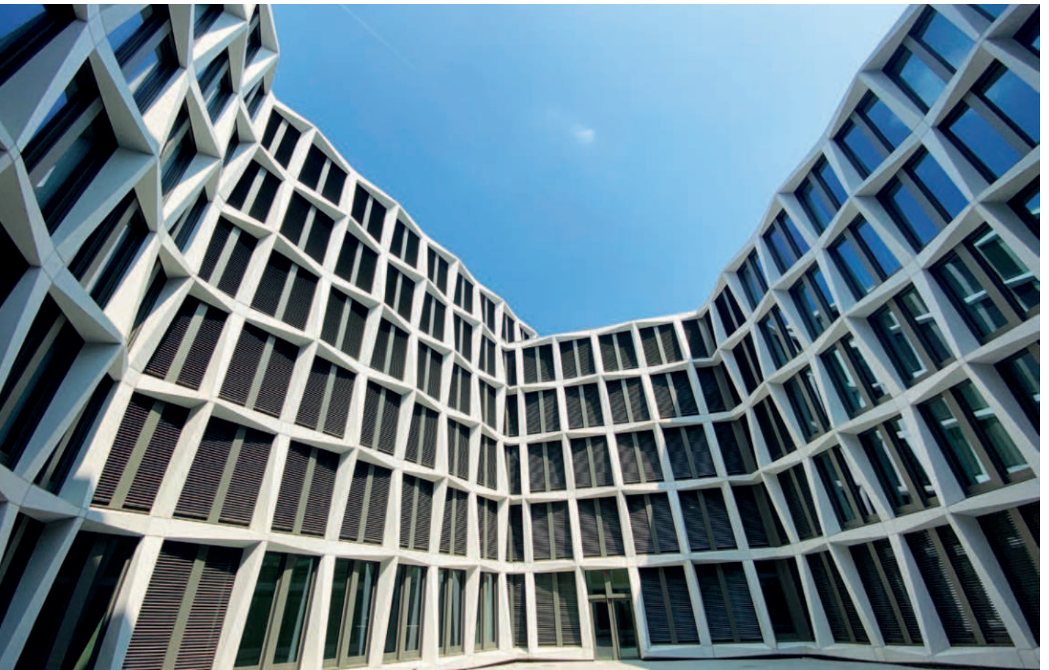
Architekturbetonfassade als lastabtragende Außenwand
