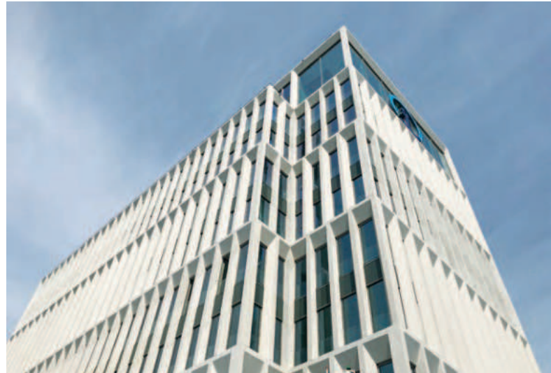
Architekturbetonfassade als lastabtragende Außenwand
