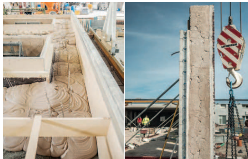
Neuartige Fassadenbauteile mit Mineralschaumdämmung
